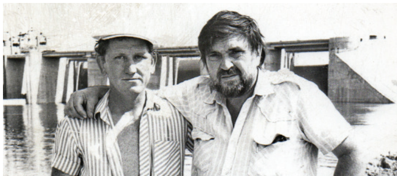
Cu Horia Pătrașcu autorul Reconstituirii , pe Șantierul Hidrocentralei Rusănești la devierea Oltului prin baraj, iunie 1989
